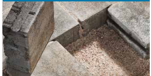
Abb. 33: Das Regenwasser versickert durch definierte Fugen und Sickerkanäle.
