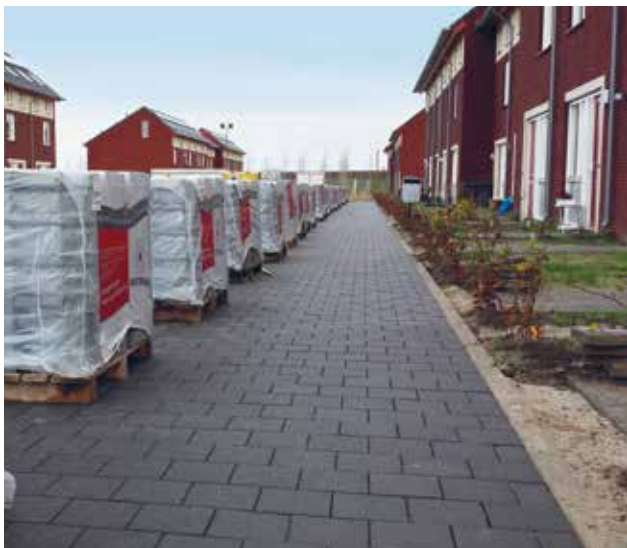
Abb. 53: Vor dem Einbau steht die Prüfung
