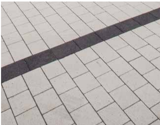
Abb. 59: Fugen immer vollständig verfüllen!
