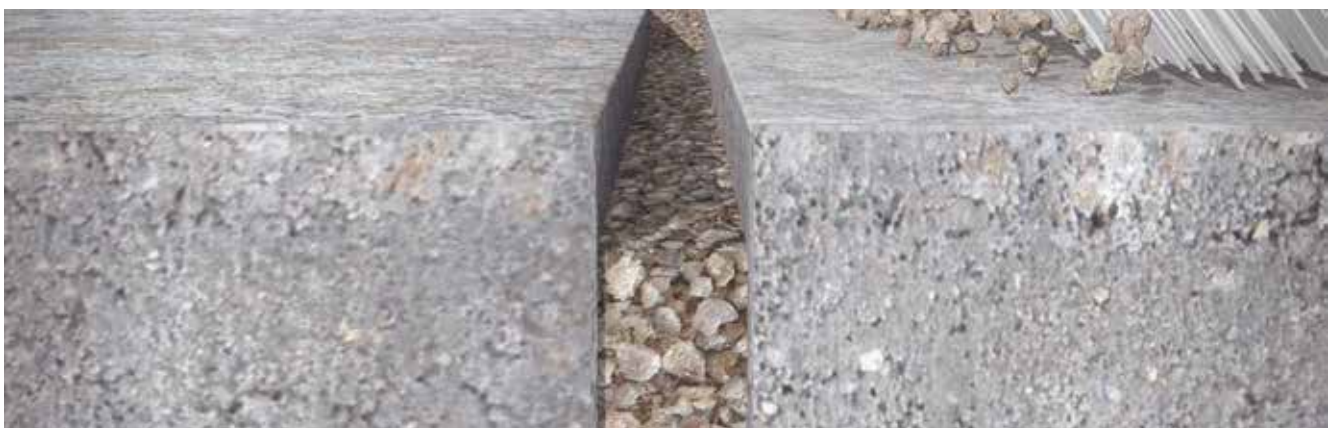
Abb. 67: Auffüllen/Einfegen mit neuem Fugenmaterial bis Oberkante Fuge
