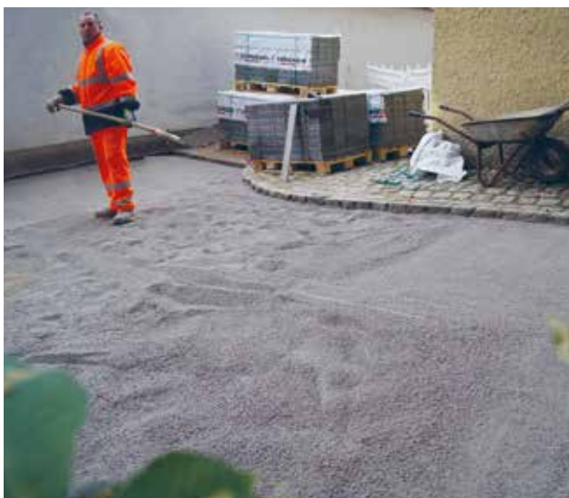
Abb. 58: Einbringen des Bettungsmaterials
