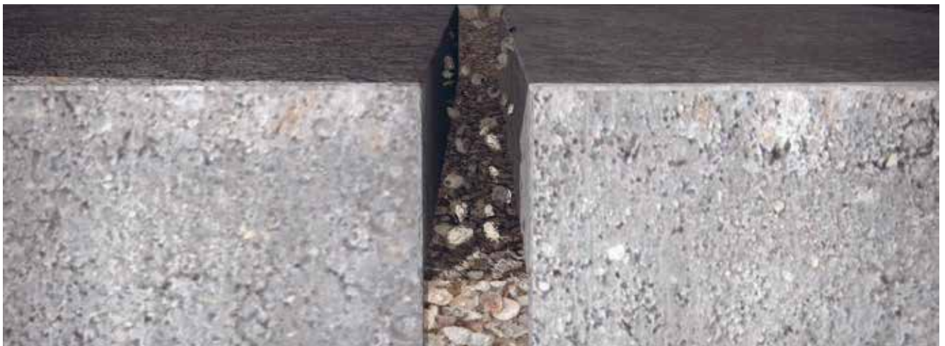
Abb. 66: Ausspülen und Absaugen des oberen (2-3 cm) verunreinigten Fugenmaterials
