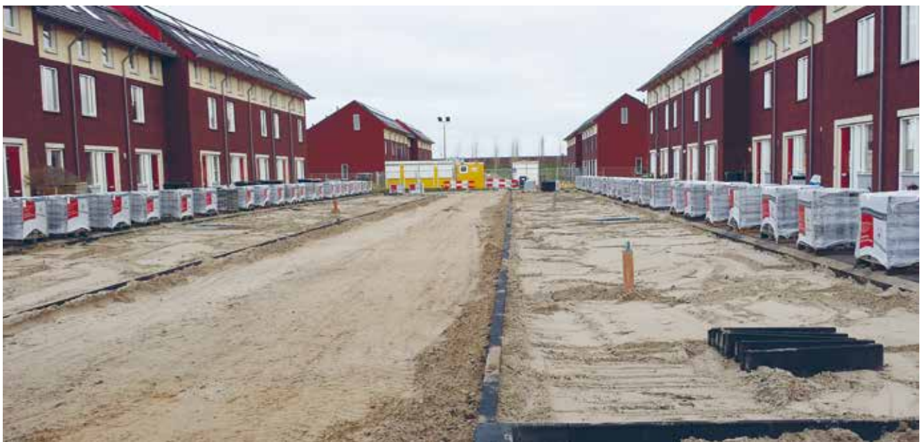
Abb. 57: Für den weiteren Aufbau müssen die Schichten sorgfältig planiert werden
