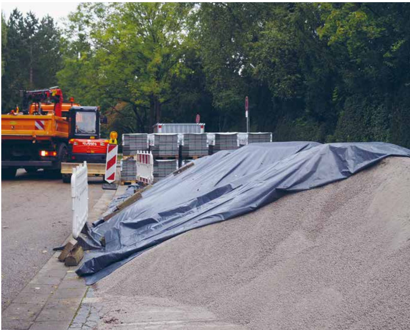
Abb. 44: ECOSAVE protect Bettungs- und Fugenmaterial muss auf der Baustelle vor Entmischung geschützt werden
