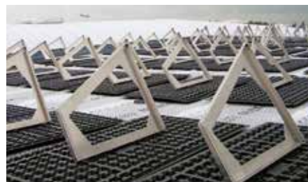
3. Auf den Solarbasisplatten werden die Solar-Grundrahmen platziert, ausgerichtet und mit nur zwei Muttern befestigt..
