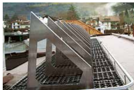
Rahmen 45° für Solar-Thermie auf 5° geneigter Dachfläche.
