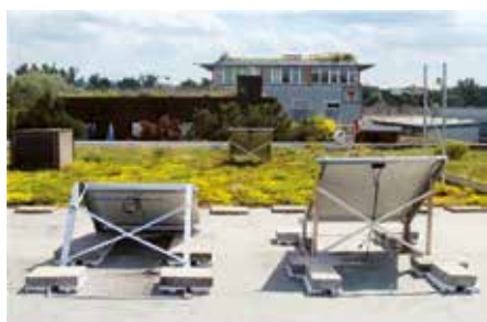
Beim Versuchsaufbau auf einem ZinCo Dach wurden die Temperatur-Differenzen verschiedener Dachaufbauten über ein gesamtes Jahr hinweg gemessen.
