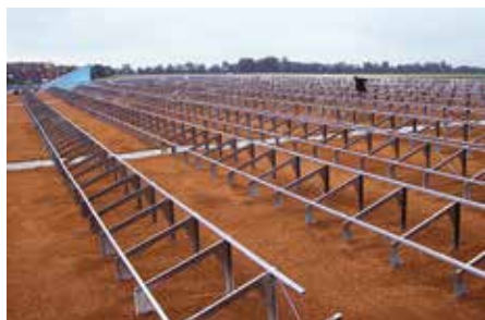
4. Entsprechend der notwendigen Auflast werden die Solarbasisplatten mit Systemerde überdeckt.
