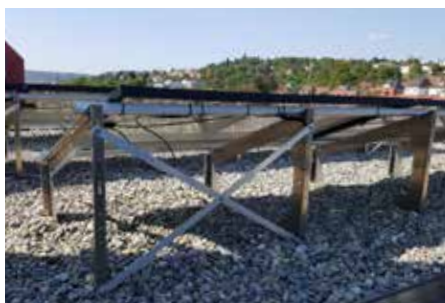
Vorgelochte Aluminium-Flachprofile, zur kreuzweisen Aussteifung zweier Solar-Grundrahmen.
