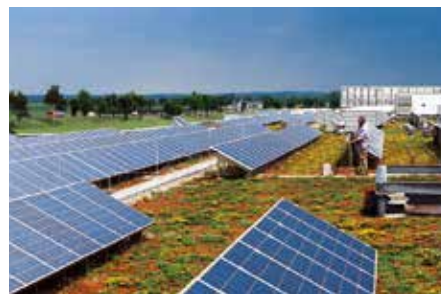
6. Das fertig begrünte Dach mit Solaranlage.
