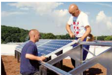
5. Die Solarmodule werden montiert.
