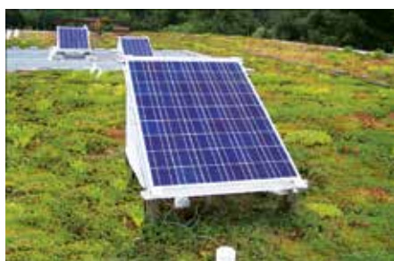
Hierbei wurden zwei Module über „nackten“ Bitumenbahnen und ein Modul über einer Dachbegrünung gegenübergestellt. Hauptaugenmerk galt den jeweiligen Temperaturen an den Unterseiten der Module.
