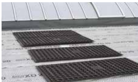
2. Anschließend werden die Solarbasisplatten ausgelegt.
