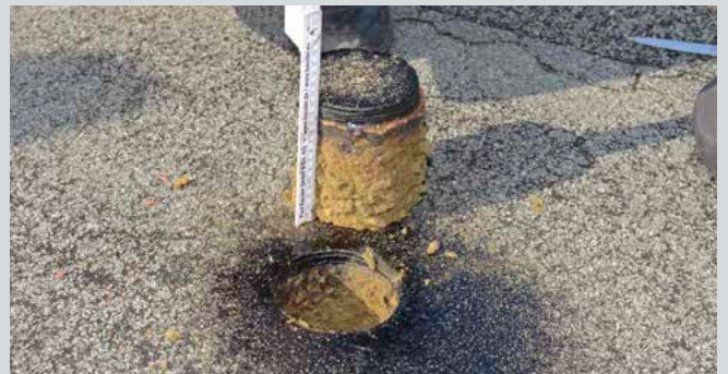
Abb. 17/2: Der Dachaufbau ist bis zur Dampfsperre einsehbar. Die entnommene Wärmedämmung wird geprüft und anschließend die geöffnete Stelle wieder fachgerecht abgedichtet.
