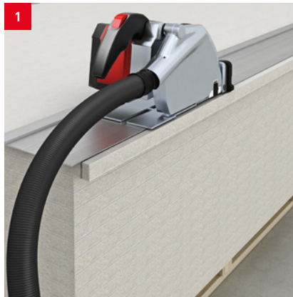
Aestuver® Brandschutzplatten werden mit schienengeführter Handkreissäge zugeschnitten
